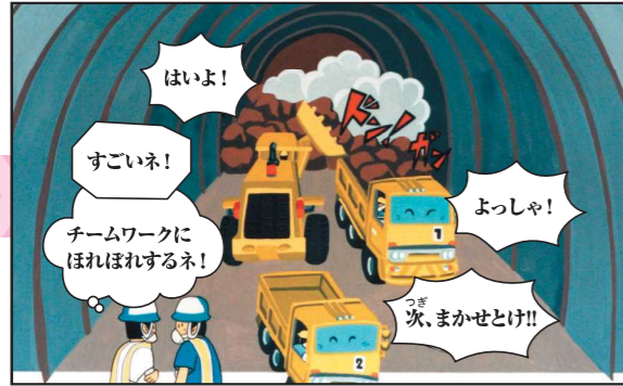
4 ずり出し 掘って出た土や岩(ずり)をトンネルの外に運び出します。
