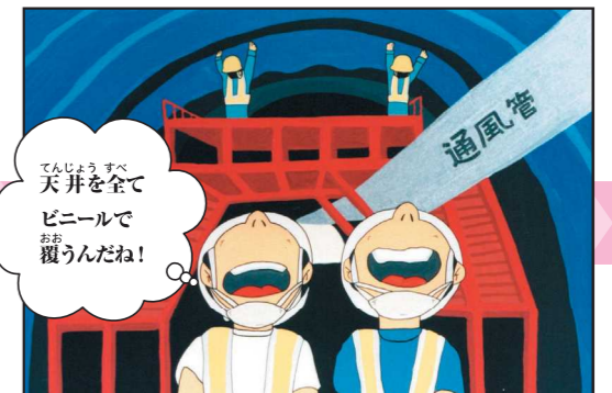
11 防水工 地下からの水がトンネルの中に漏れないように、ビニールシートを取り付けます。
