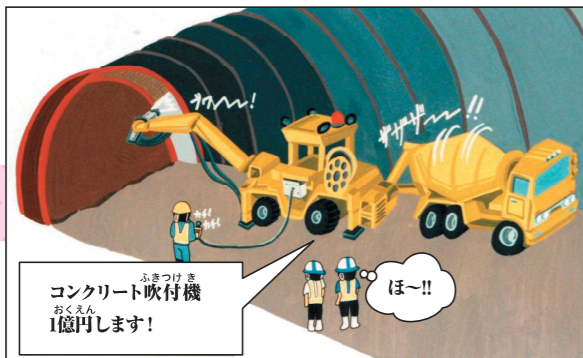
8 二次吹付 金網と支保工をコンクリートでつないで補強します。
