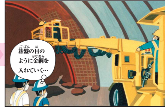
6 金網取付 トンネルを補強するために金網を取り付けます。
